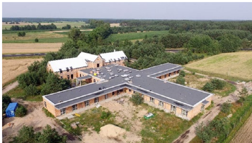
Budowa hospicjum stacjonarnego w Makówce
